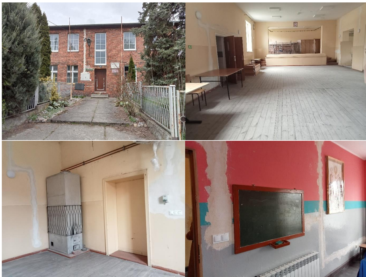
Rycina 20 Budynek byłego Domu Katolickiego w Siemianicach
