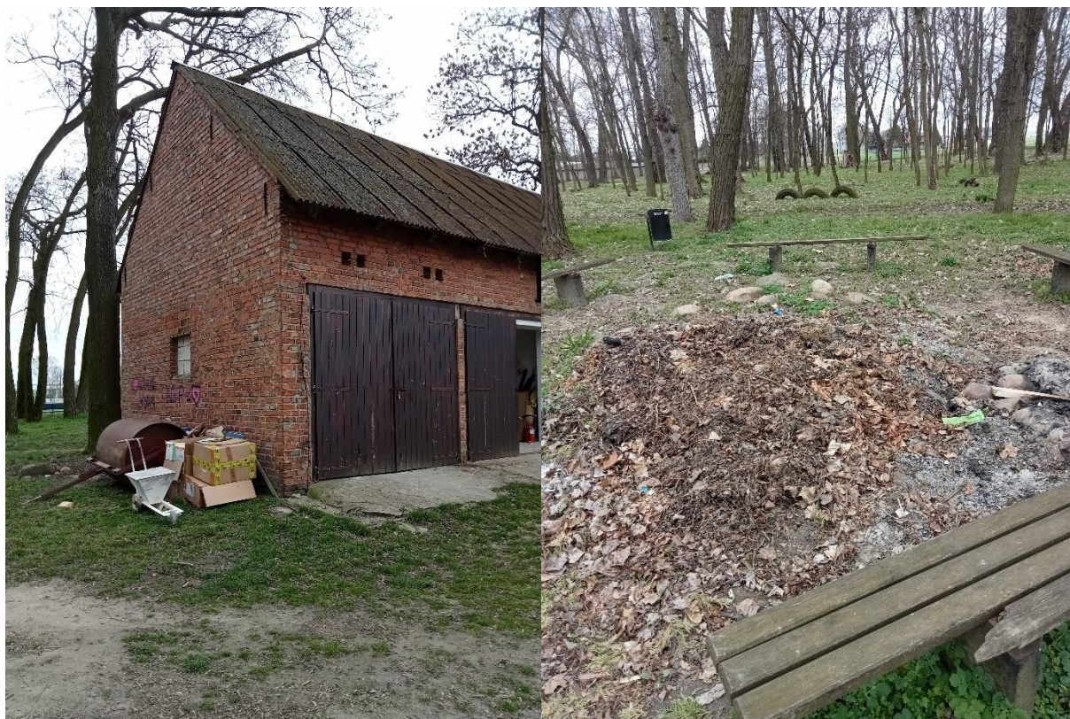
Rycina 18 Stan techniczny obiektów przy parku w Łęce Opatowskiej
