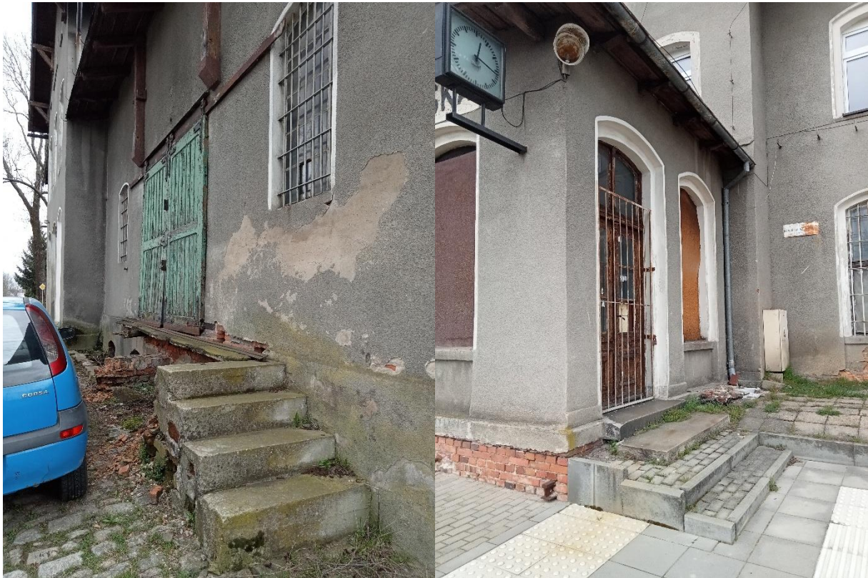
Rycina 19 Budynek byłego dworca PKP w Łęce Opatowskiej
